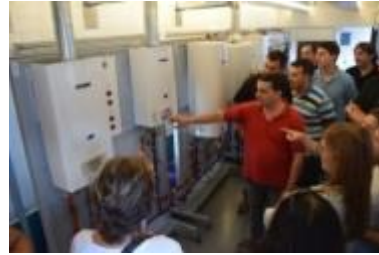
Curso Solar Térmico en Escuela Técnica 281, Firmat, Santa Fe.
